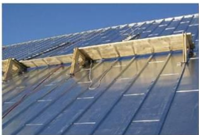
Figure 20 - Toiture en tôle à baguette
