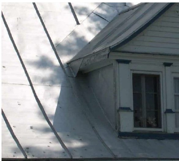
Figure 22 - Toiture en tôle pincée ou agrafée
