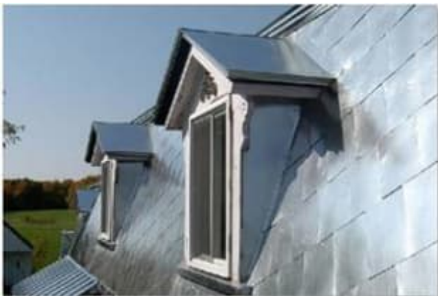
Figure 21 - Toiture à la canadienne
