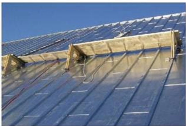
Figure 20 - Toiture en tôle à baguette
